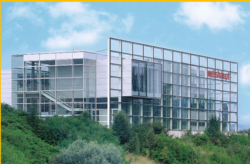
Schulungs- und Verwaltungsgebäude in Geroldswil (ZH)
